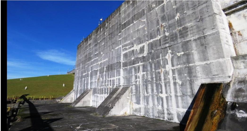
**Ilustração 12** – Processos de lixiviação na parede de jusante e infiltração na base de um dos contrafortes.
